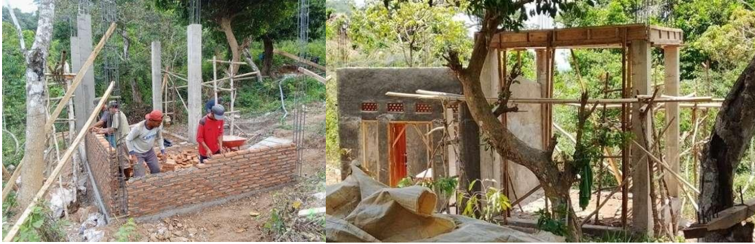
Konstruksi Pembangunan perencanaan penampungan air Desa Sambori
