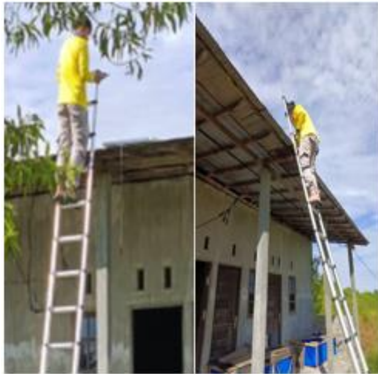
Gambar 3. Pemasangan perangkat panel surya
