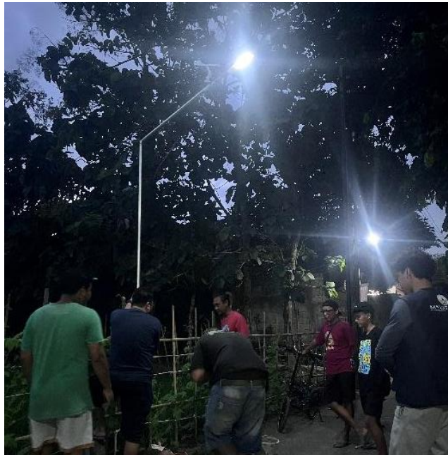
Gambar 11. Pemasangan Instalasi PJU
