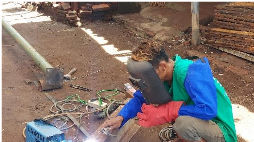
Gambar 4. Pekerja las telah menggunakan beberapa APD ketika melakukan pekerjaan pengelasan.
