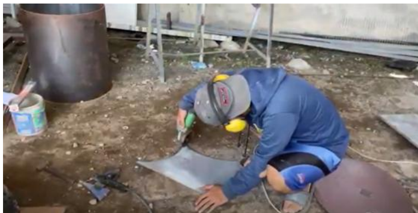
Gambar 11. Proses Pembuatan Mesin
