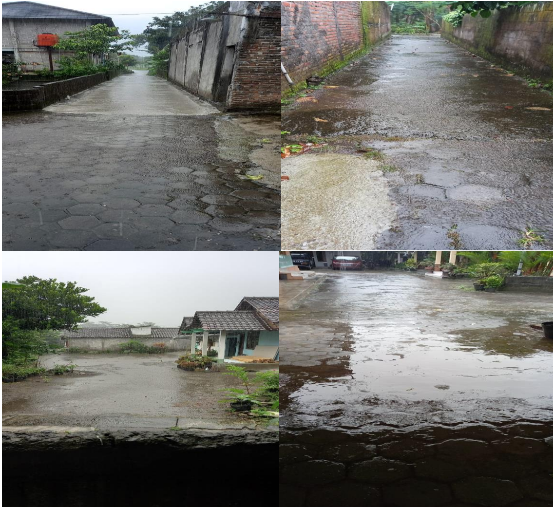
Gambar 1. Penampakan ruas-ruas jalan perkampungan dusun Krandon dan halaman rumah yang dicor beton dan paving block (hasil observasi lapangan)
