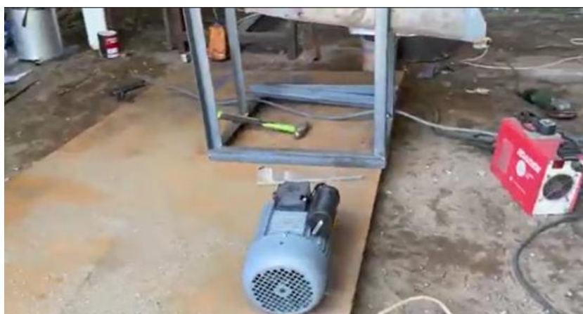
Gambar 12. Proses Pembuatan Mesin
