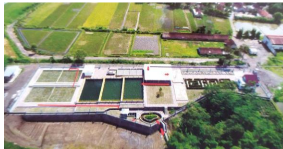
Gambar 1. Tampak Atas IPALD-T Skala Permukiman Berbah
