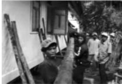
Gambar.4. Pembangunan Hunian Di Kampung Naga Digunakan Konsep Tradisional Agar Tidak Menghasilkan Emisi Co2.
