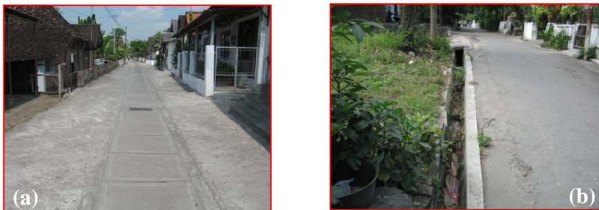
Gambar 4. Saluran Drainase di Nitiprayan: Sistem Tertutup (a); Sistem Terbuka (b)
