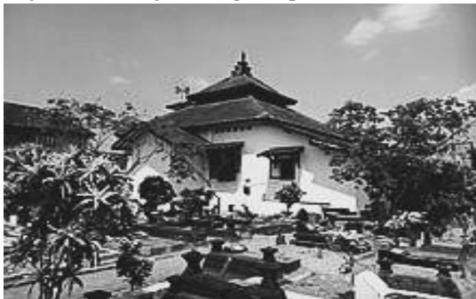
Gambar. 3 Masjid Ad-Darajat Banguntapan
