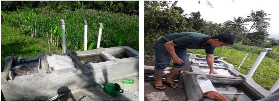
Gambar 3. Perbaikan kualitas tandon air
