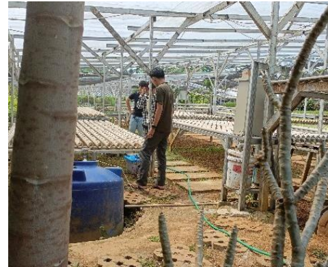
Gambar 5. Pengujian pemasangan sistem pengkabutan
