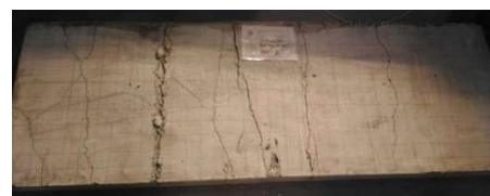
Gambar 7 Pola kerusakan benda uji tekan PP-T2
