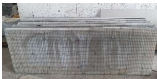
Gambar 2. Dinding panel setelah dipasang kawat loket
