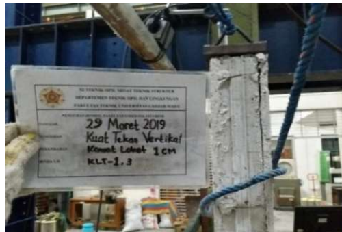
Gambar 10. Kerusakan dinding panel KLT-1, 3
