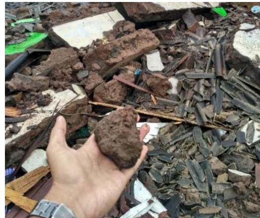
Gambar 2. Campuran beton yang kurang baik (Saputra & Faizah, 2019)
