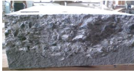
Gambar 11. Pola keruntuhan balok B0
